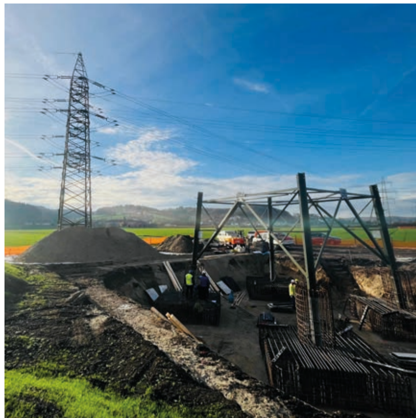
Die Maststockungen liegen voll im Zeitplan.
