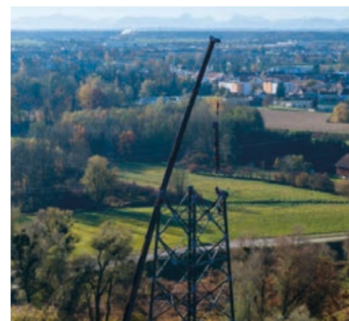
Die Bauarbeiten laufen auf Hochtouren.
