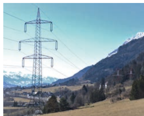
Die APG investiert in die Generalerneuerung der Ennstalleitung rund 220 Mio. €.
