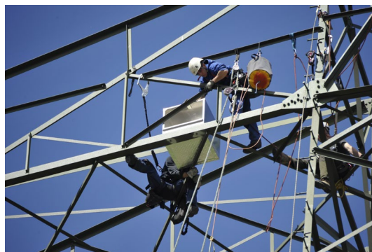
Abbildung C.2 Montage eines Brutkastens
